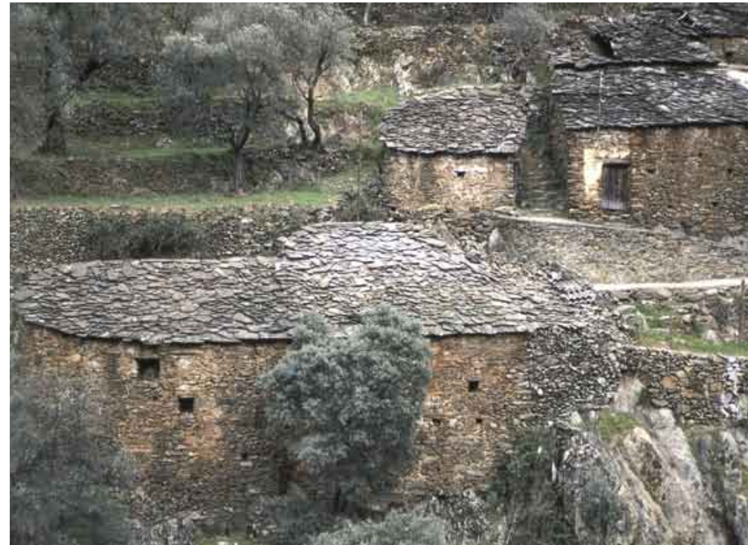
Construcciones típicas de Las Hurdes.
