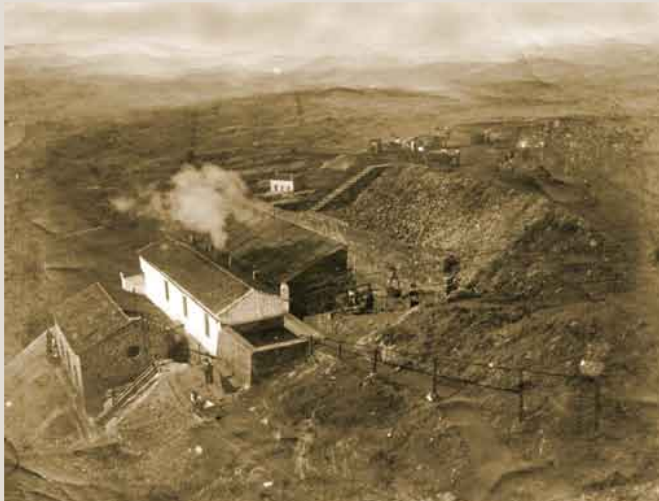
Aspecto de las instalaciones (cargadero, teleférico, edificaciones...) durante la explotación de la Mina.
